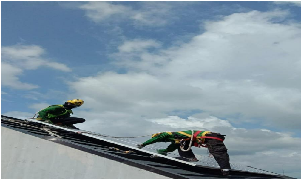
Gambar 1.1 Teknisi Yang Sedang Memasang Modul PV Diketinggian
