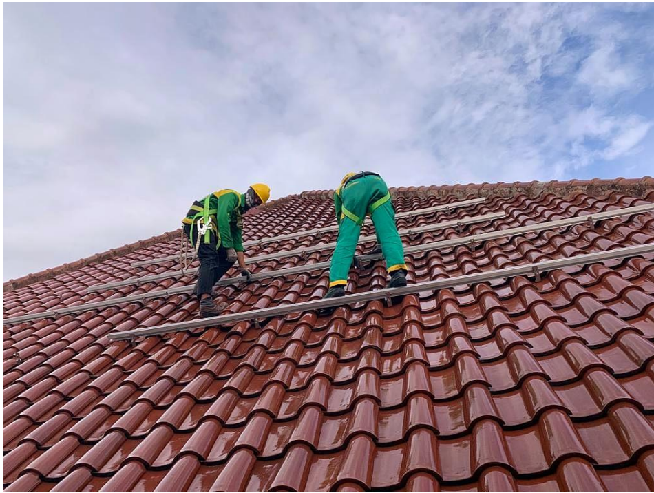
Gambar 1.2 Teknisi Yang Sedang Memasang Bracket Diketinggian
