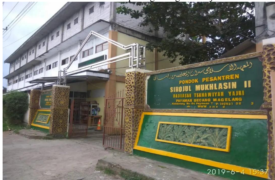
Gambar 4.1: Kondisi fisik pintu gerbang PP.Sirojul Mukhlisin II.
