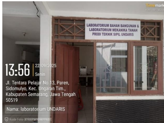
Gambar 3.2 Laboratorium Bahan Bangunan Dan Mekanika Tanah UNDARIS.
