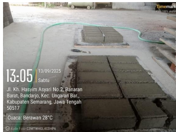
Gambar 3.14 Pengeringan Paving Block setelah dicetak.
