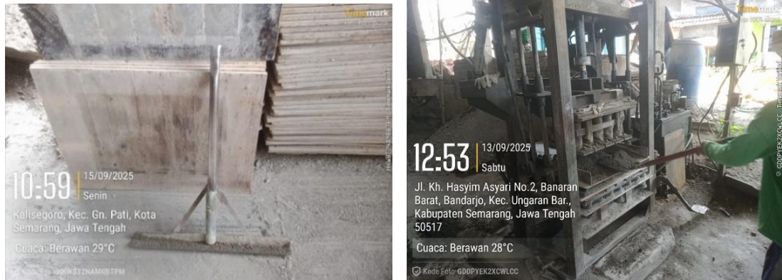
Gambar 3.11 Pengisian Cetak Paving dengan Adonan dan di ratakan dengan alat perata
