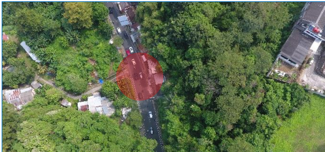
Gambar 1 Foto Udara Lokasi Amblasan Jalan Gombel Lama Semarang
