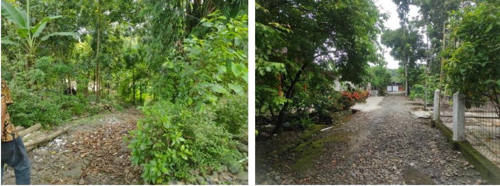
Gambar 4-4. Kondisi Jalan Pendekat ke Lokasi Rencana Jembatan Gantung
