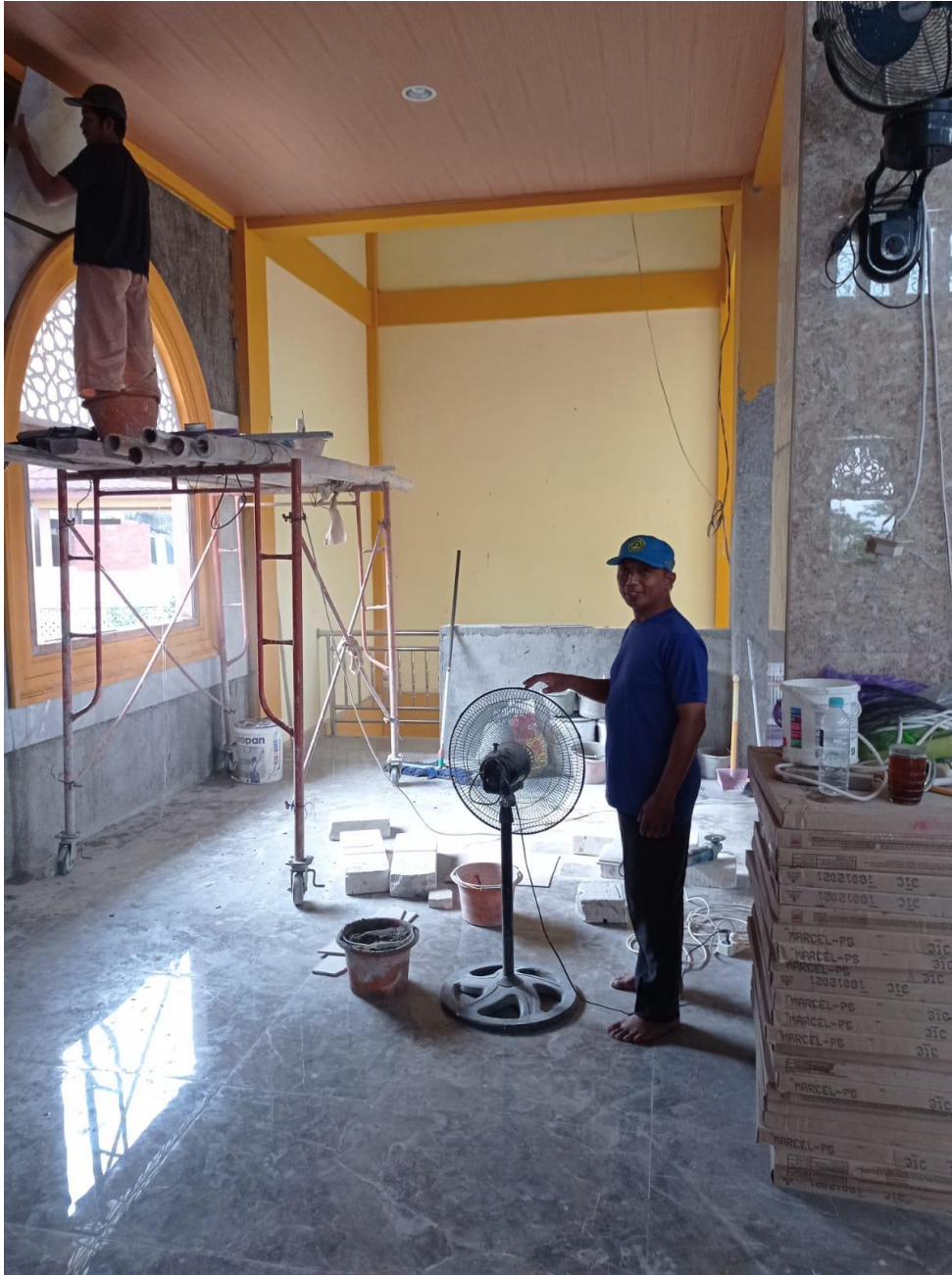
Gambar 5.12. Pemasangan Dinding Granit Lantai 2
