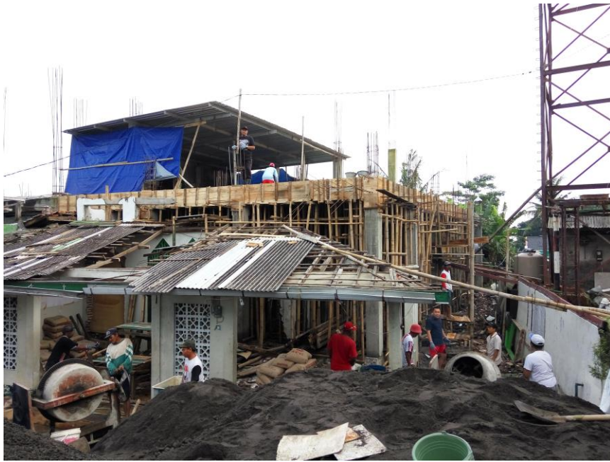
Pekerjaan pengecoran balok dan dak beton
