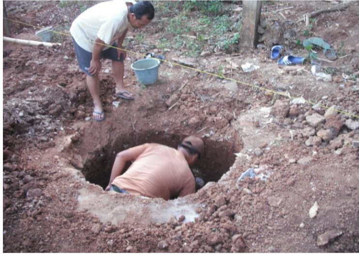
Gambar Pekerjaan Galian Pondasi
