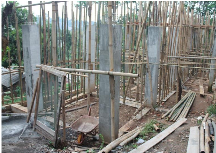
Gambar Pekerjaan Kolom
