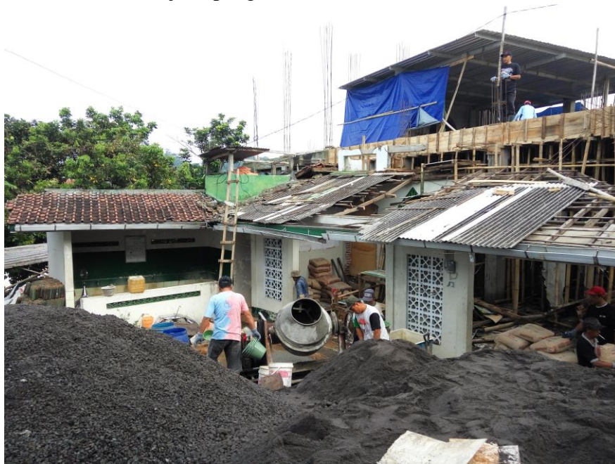
Pekerjaan pengecoran balok dan dak beton
