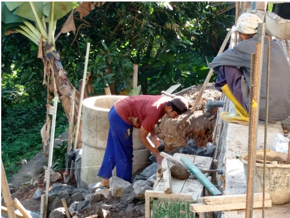
Gambar 5.6. Pemasangan Talud Pada Septic Tank
