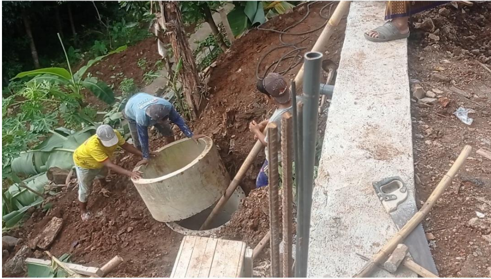
Gambar 5.5. Pekerjaan Pemasangan Buis Beton
