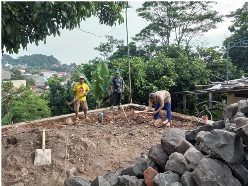
Gambar 5.2. Pelaksanaan Pekerjaan Tanah
