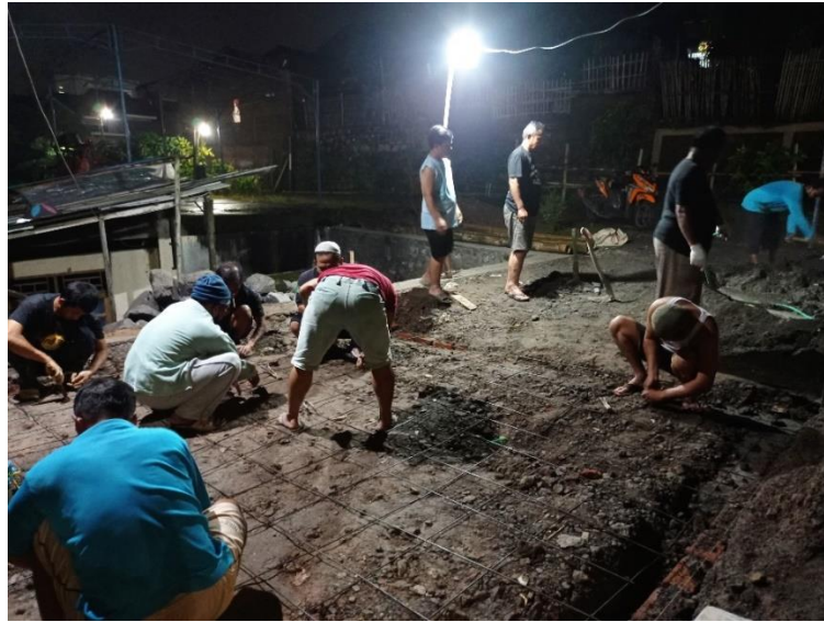
Gambar 5.3. Pengecoran Lantai Tempat Pemotongan
