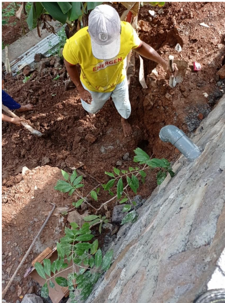
Gambar 5.4. Pekerjaan Galian Septic Tank
