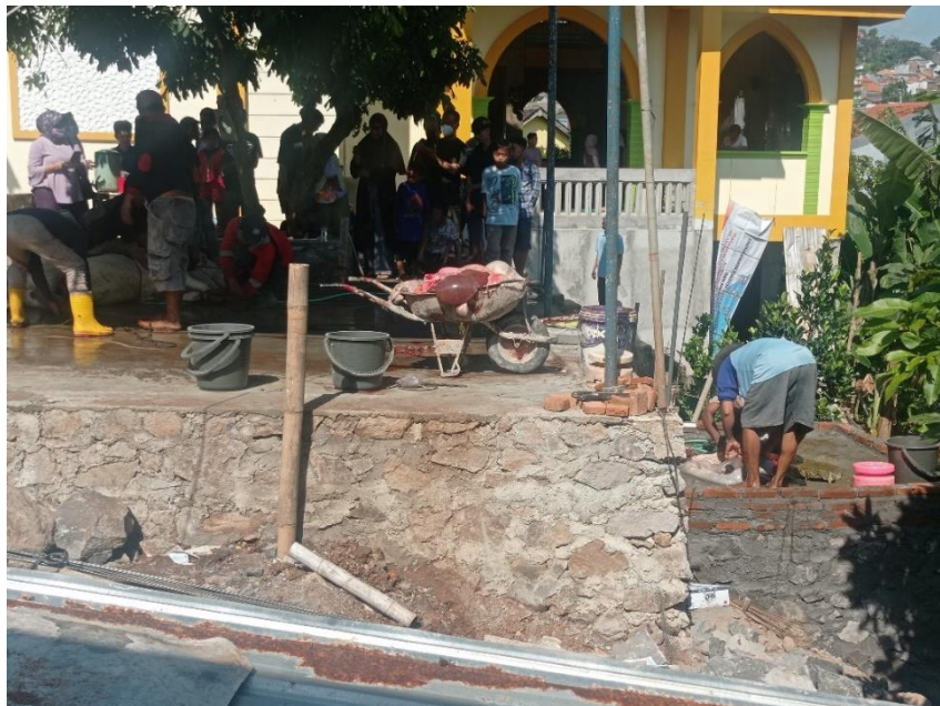
Gambar 5.9. Penggunaan Septic Tank Limbah Kurban
