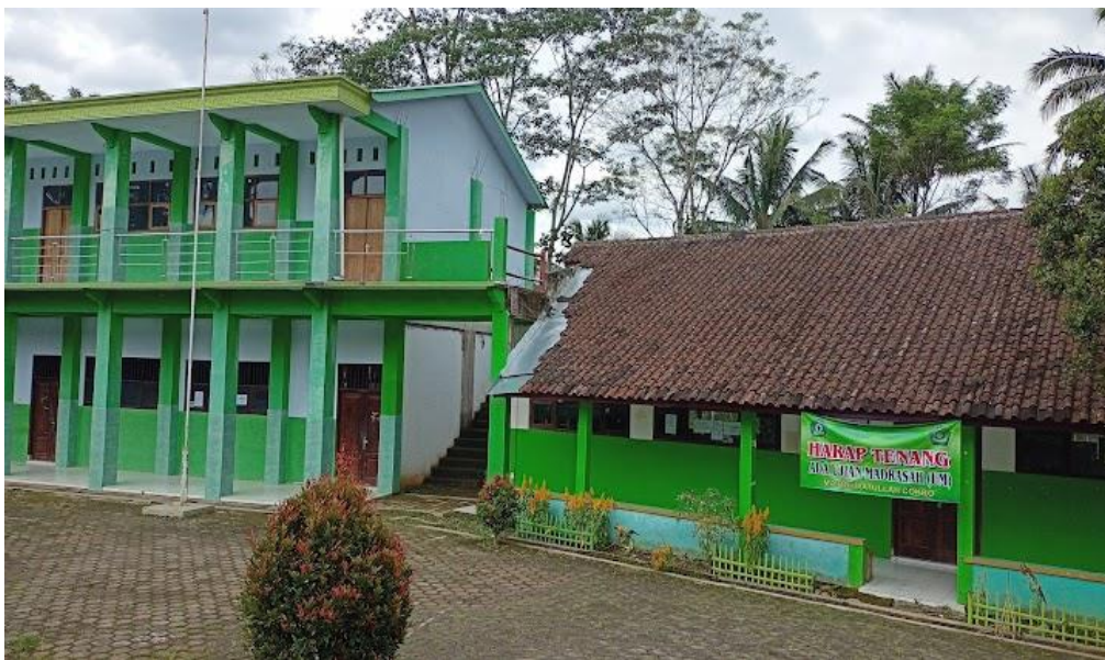
Foto MA Rohmatullah Cokro
