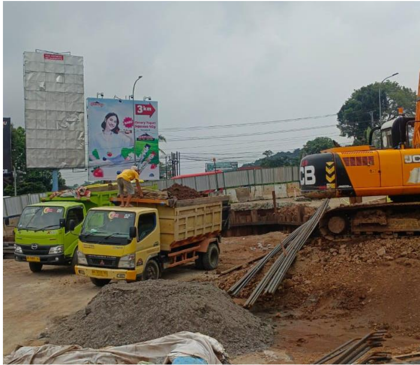
1.9 Pengerjaan Jalan Tol Yogya-Bawen
